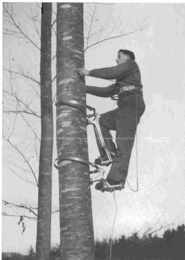
Le modèle normal est livré avec une paire de rubans d'acier garantis contre la rouille de 2,70 m de longueur, qui conviennent pour l'escalade d'arbres de jusqu'à 65 cm de diamètre de tige. Des rubans plus courts ou plus longs sont aussi à disposition.
